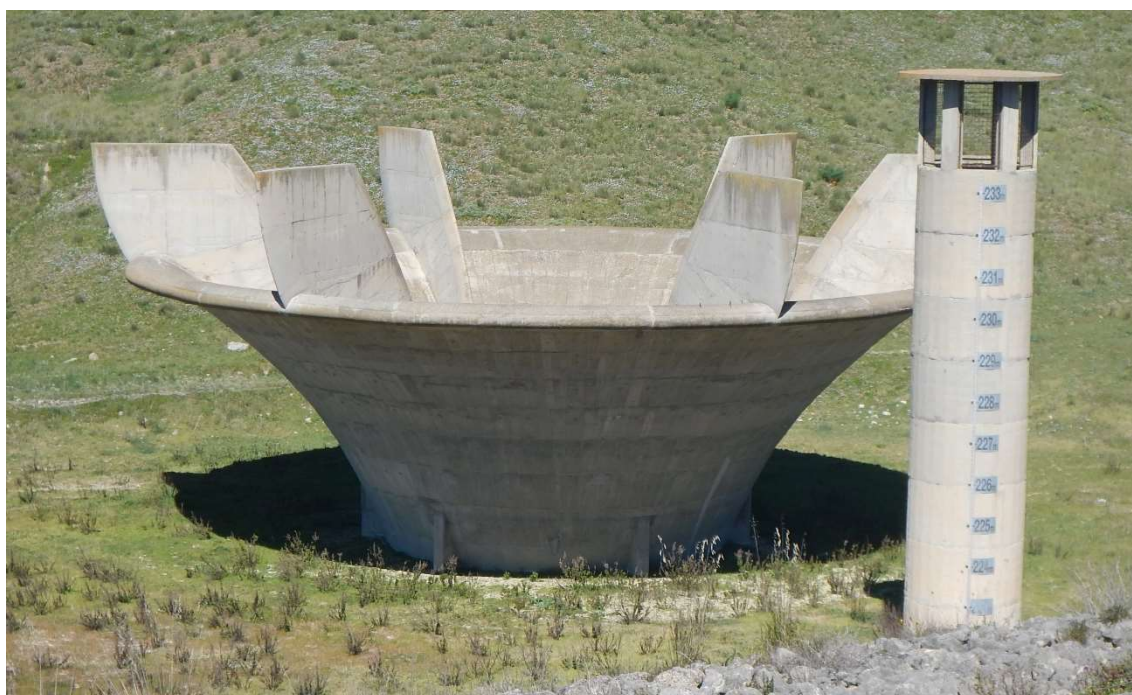
Figura 3.5: Sfioratore a calice sinistro e suo torrino aeroforo
